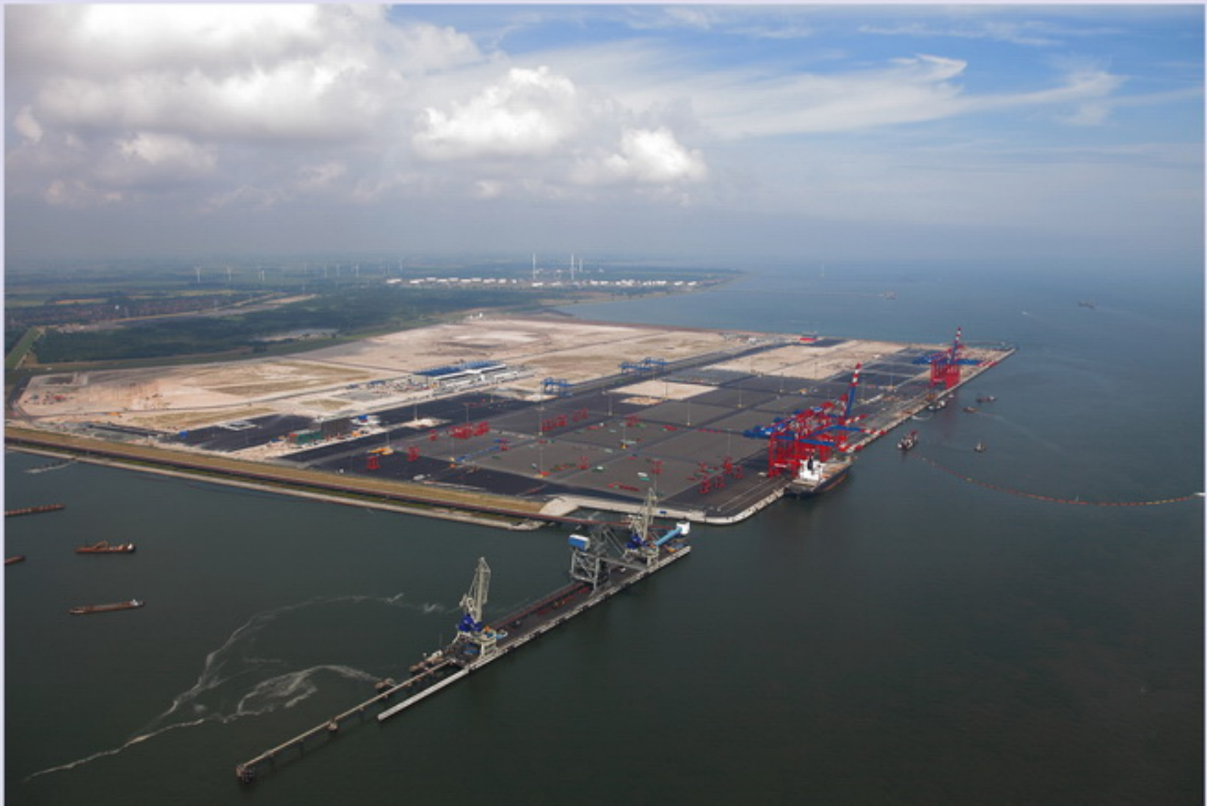
Der „Jade-Weser-Port“ während der Bauphase.
